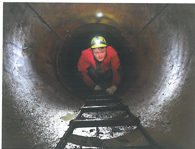
Foto 1 Laminátové Hobas skruže v labilních sedimentech na dně Ústřední propasti (Foto I. Flek)
